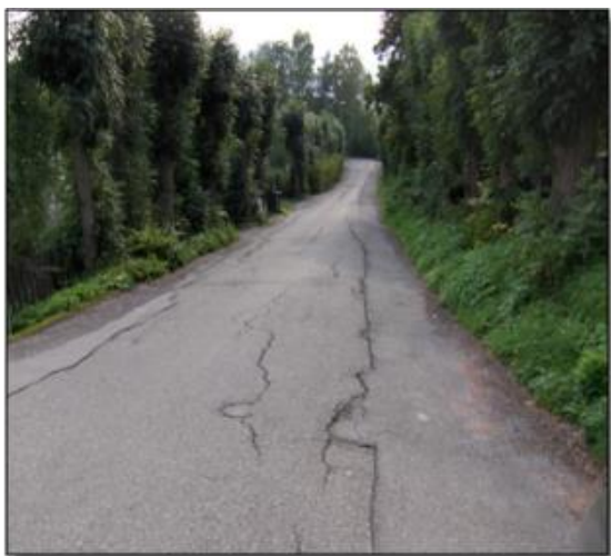
Langsgående sprekker i asfaltdekke.
