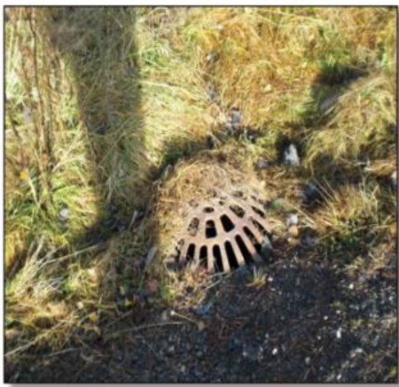
Manglende rensk rundt kuppelrist reduserer rista sin kapasitet.
