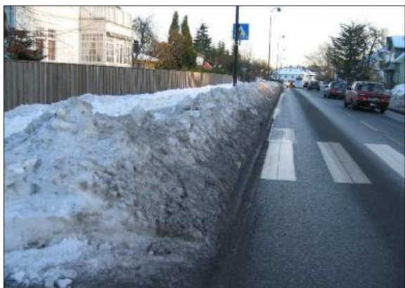
Manglende prioritering av fotgjengerovergang i forbindelse med brøyting.
