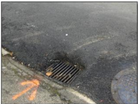
Manglende heving av sluktopp ved asfaltering kan gi nivåsprang.
