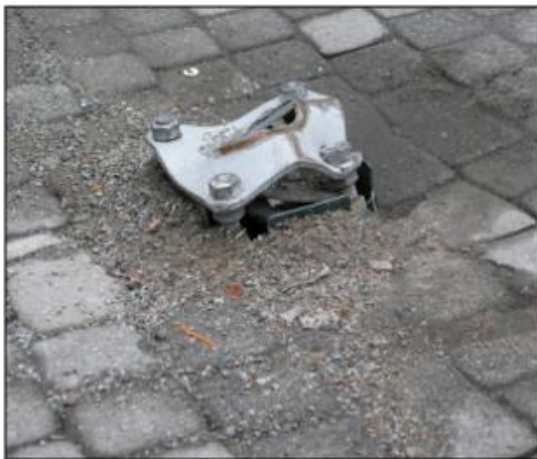
Manglende sikring/varsling av mastefundament medfører fare for å snuble
